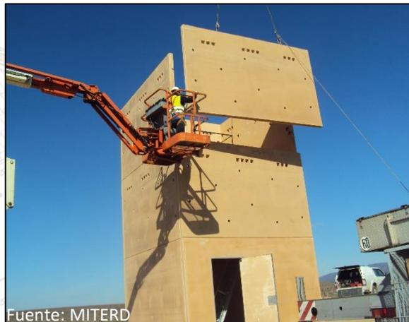
Colocación de los paneles prefabricados tras la cimentación del terreno
