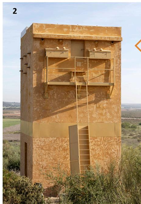
Primillar tradicional (original a la derecha), readaptado al nuevo modelo sin cubierta. En el exterior permanecen algunas repisas, los orificios fueron eliminados todos.
