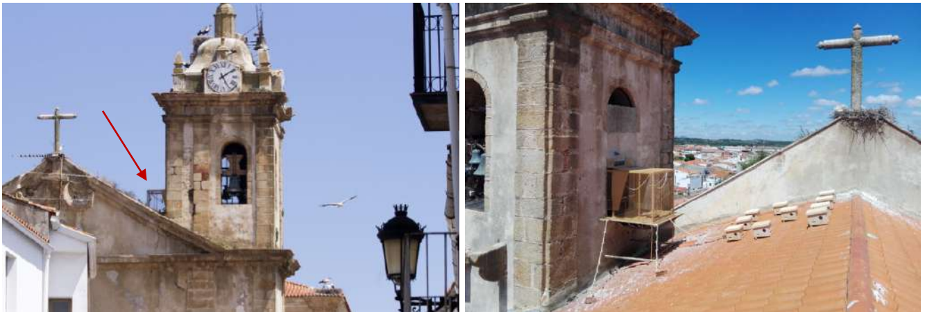
Fig. 4 – El módulo de liberación se instaló tras la torre, en el rincón situado entre esta y el muro principal de la fachada para reducir el impacto visual desde el exterior
