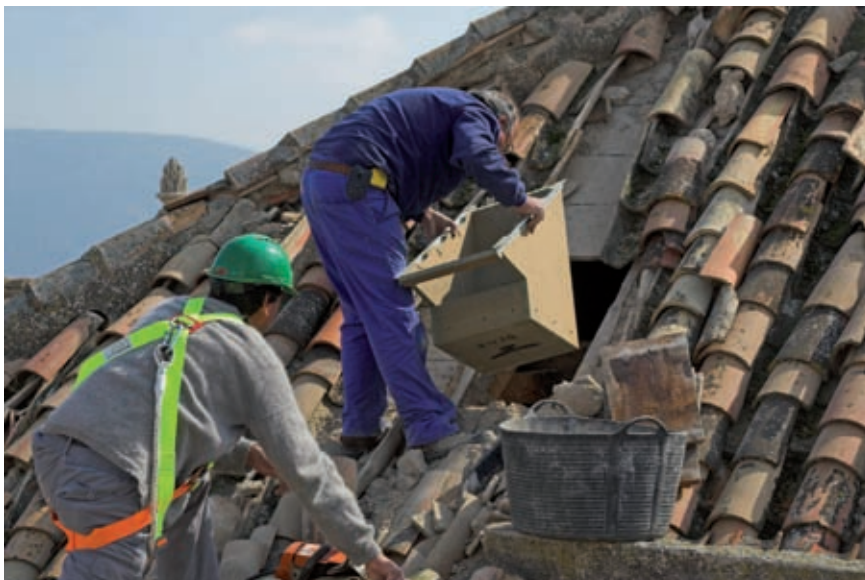
Foto 8. Nidales definitivos bajo la cubierta de un edificio   Jos  Antol n
