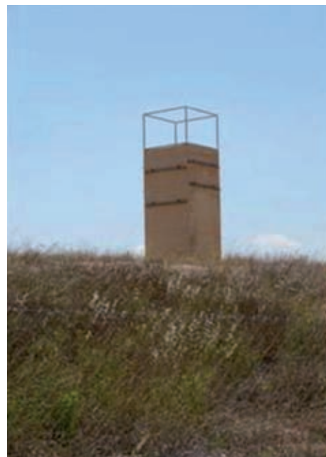
Fotografía 2. Primillar y talud resembrado
