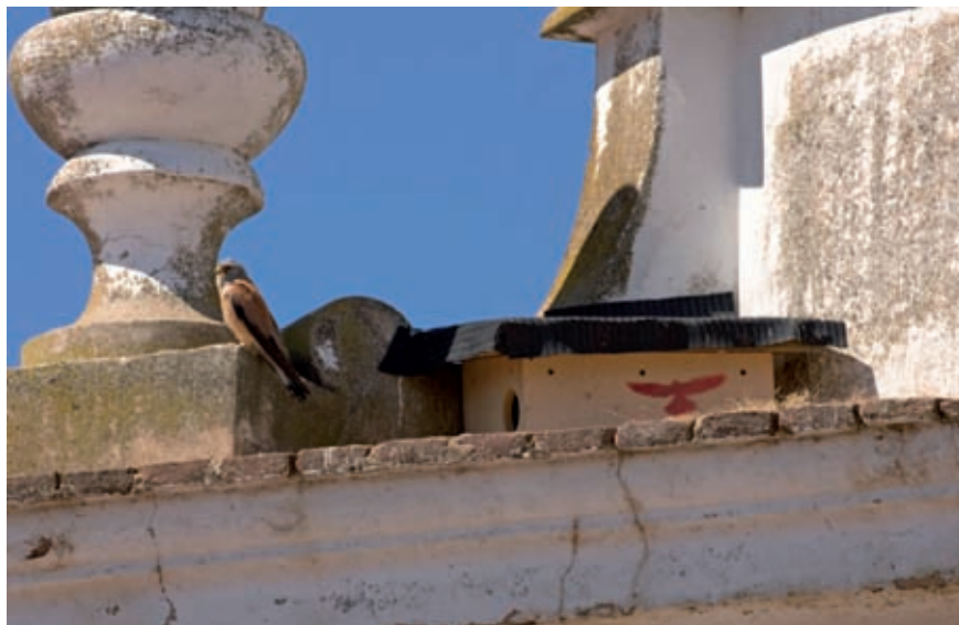
Foto 4. La instalación de niales provisionales ha evitado la desaparición de colonias, en restauraciones realizadas en época de cría © José Antolín
