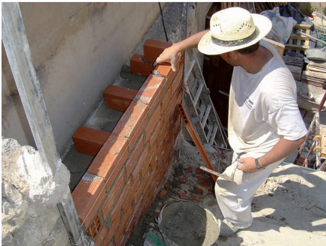
Fotografía 2. Construcción de niales en muro de futuro primillar. Caralluma ©.
