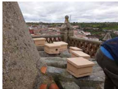
**Fig. 3.** Colocación de nidos prefabricados exteriores en inmuebles con protección patrimonial.
