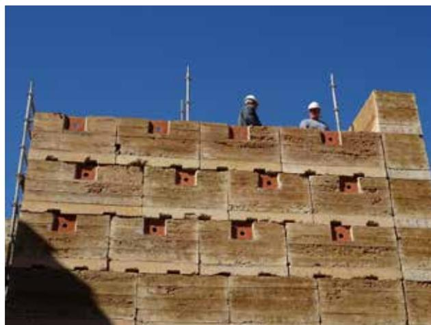
**Imagen 3.** Obras de adecuación del sustrato de nidificación. Construcción de tapial integrando mechinales adaptados.
