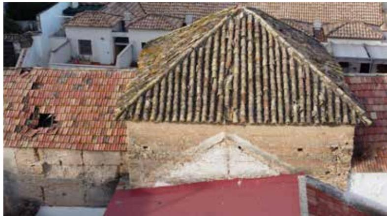
**Fig. 27.** Vista aérea de las cubiertas, que están gravemente deterioradas, parte del techo interior se ha caído.
