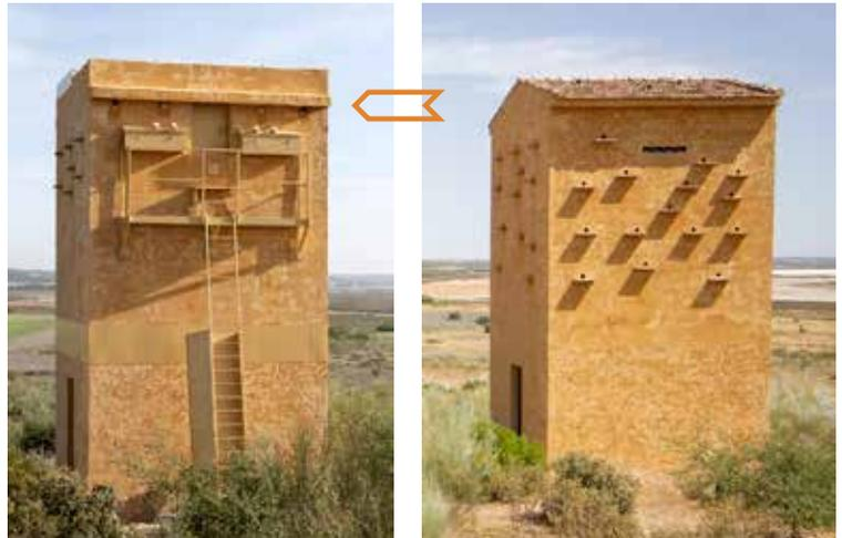
**Fig. 13 y 14.** Primillar tradicional (14), readaptado al nuevo modelo sin cubierta (13). En el exterior permanecen algunas repisas, los orificios fueron eliminados. Las cajas de liberación y el acceso al módulo, por limitación de espacio, se instalaron al exterior (13). Fuente de Piedra. Málaga
