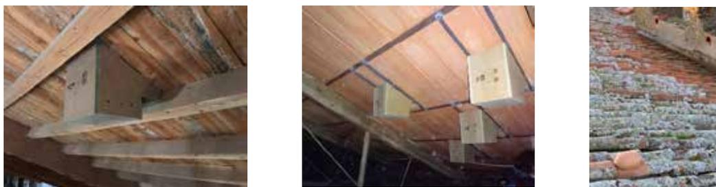
**Fig. 4.** Colocación de nidales bajo cubierta prefabricados en inmuebles con protección patrimonial.
