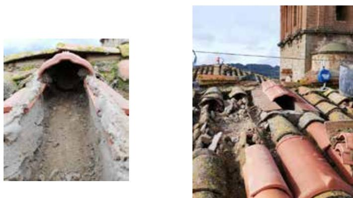
**Fig. 5.** Nidales bajo cubierta sobre bóveda con relleno y tablero.
