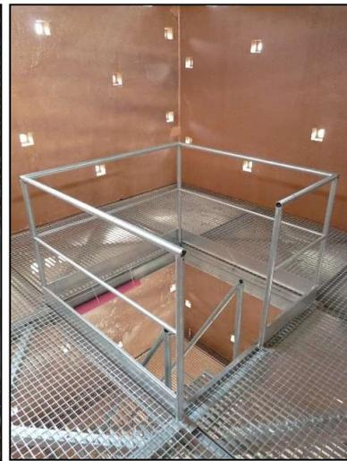
Estructuras metálicas de pisos y escaleras
