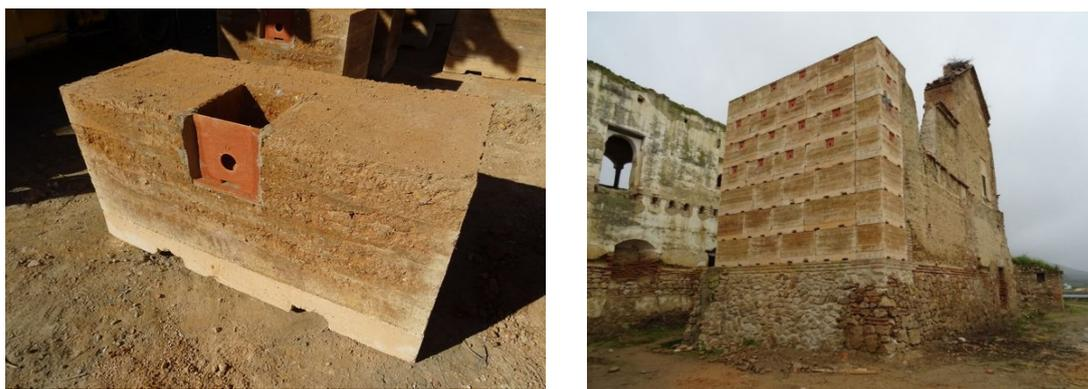
**Fig. 6.** Mechinales en muros nuevos de bloques de tapial prefabricado.
